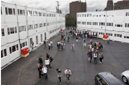
Wenig einladend: Schulcontainer am Mühlberg
